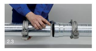
2.4 Muffenrohr und Rohrende bis zum Dichtelement zusammenführen.
