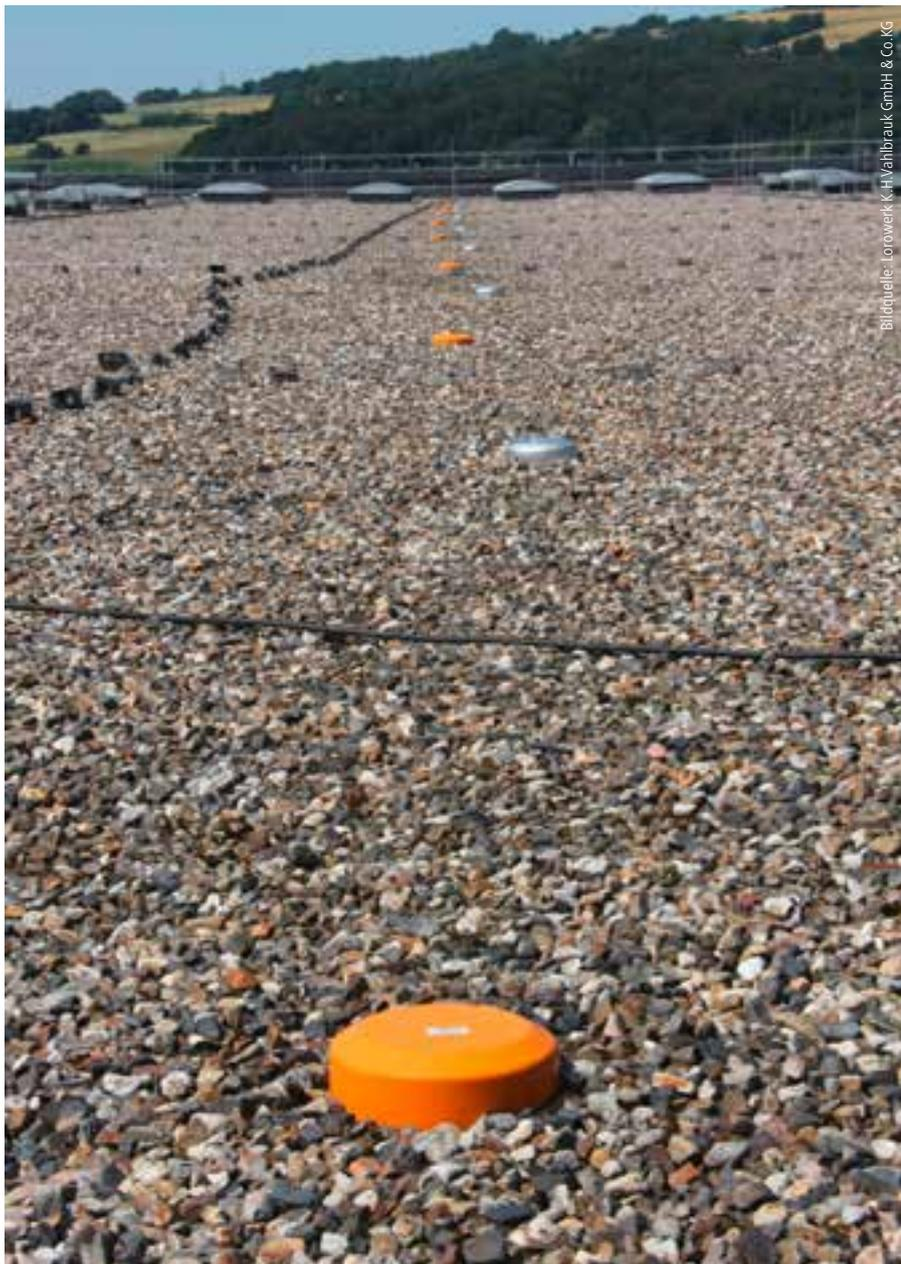
Die Lagerhalle von B. Braun in Melsungen wird nun mit Druckströmung entwässert.
