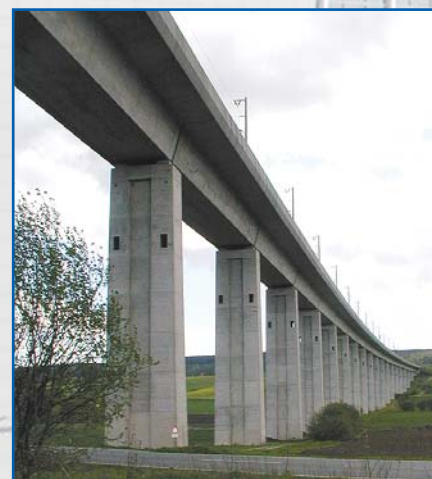
DB Trasse (Brückenbau)
