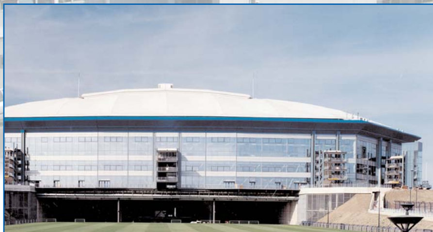
Stadionul Schalke Gelsenkirchen
