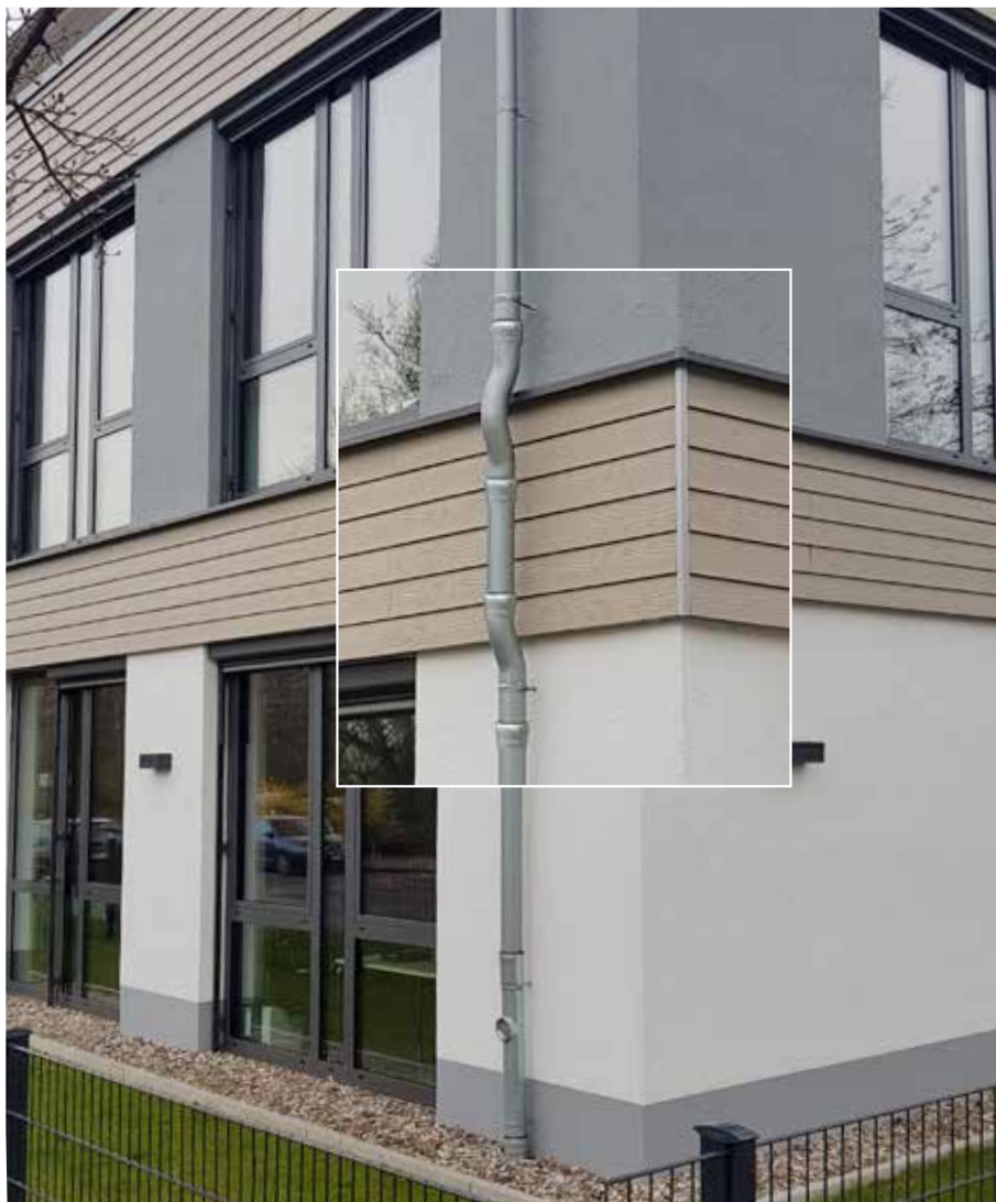
LORO-X-standpijpen en -valpijpen met offset-pijpen en bochtstukken voor het overbruggen van gevelinsprongen, zie pagina's 23 en 25.
