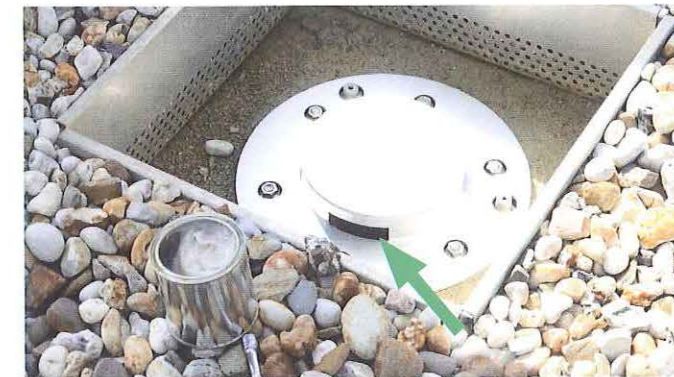
LORO-X VARIOFIT Retentionseinheit Einbau
