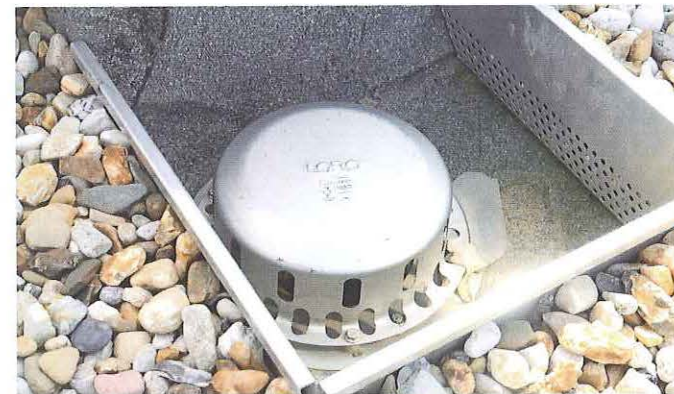
Mit Retention nachgerüster LORO-X RAINSTAR Attikaablauf
