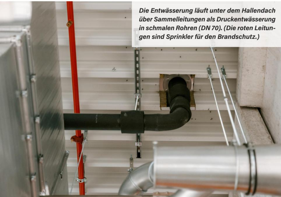
Die Entwässerung läuft unter dem Hallendach über Sammelleitungen als Druckentwässerung in schmalen Rohren (DN 70). (Die roten Leitungen sind Sprinkler für den Brandschutz.)
