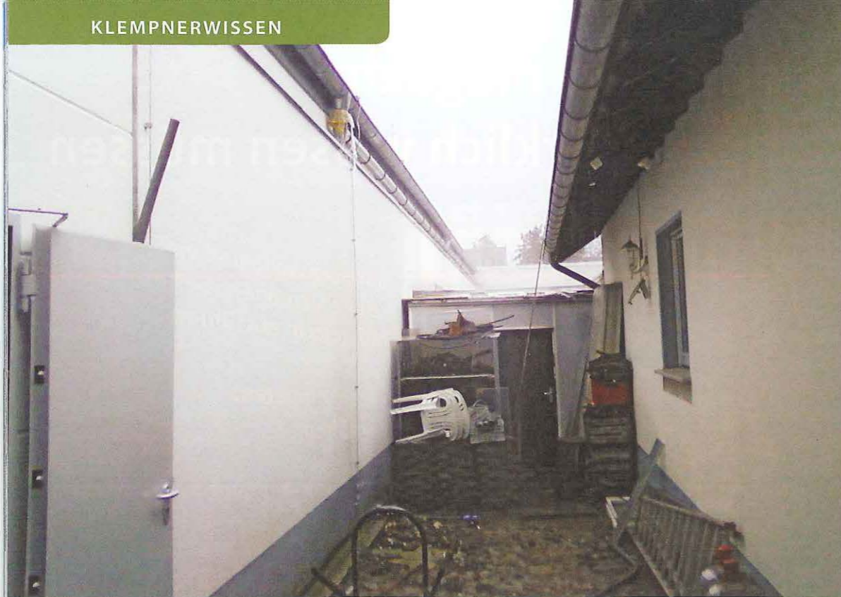
Das Beispiel zeigt die Entwässerungssituation der Lagerhalle, die in einem geringen Abstand von etwa 4 Metern neben dem Wohngebäude errichtet wurde.
