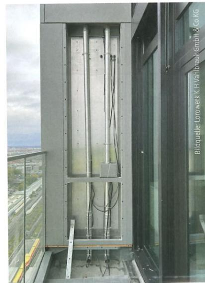
Die Niederschläge fließen von den oberen auf die darunterliegenden Terrassen, dort dann unter dem Gehbelag zu Haupt- und Not(Retentions-)Abfluss am Ende des Balkons.
