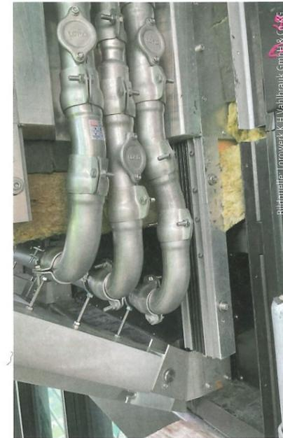
Die Stahlabflussrohre sind mit Sicherungsschellen befestigt. Sie dienen der zusätzlichen Sicherung der Rohrleitungen gegen Auseinandergleiten.
