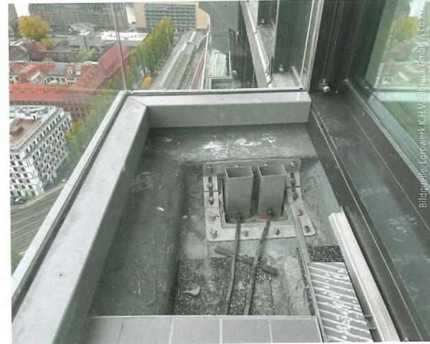
Neben der Entwässerung der Terrassen mit konventionellen Abläufen wurden Spezialabläufe mit Vierkantröhr eingebaut.
