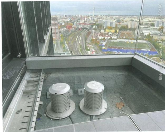
Durch Retention ist sichergestellt, dass die Entwässerung auch bei Starkregen nicht überlastet wird.
