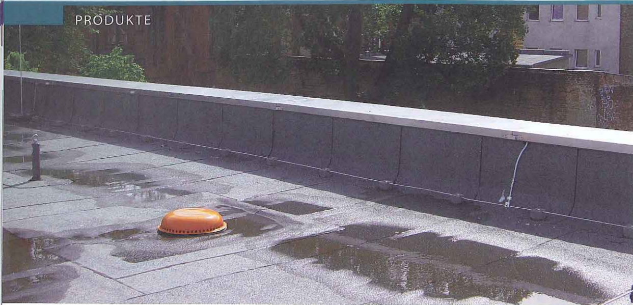
Mit nur einer Tiefpunktlinie und zwei speziellen Dachabläufen wird das 1.780 m 2 große Flachdach der Theresienschule in Berlin-Weißensee entwässert.
