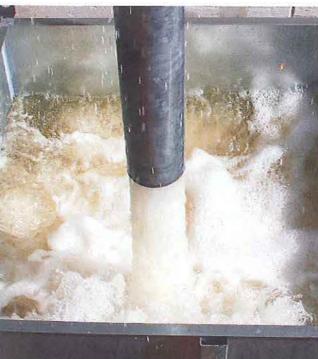
Das eingesetzte Notentwässerungssystem leistet einen Abflussbeiwert von bis zu 94,4 l/s bei 75 mm Wasserhöhe. Dies bietet eine erhöhte Sicherheit gegenüber der normativen Berechnung auf Basis der durchschnittlichen Jahrhundert-Regenspense.
