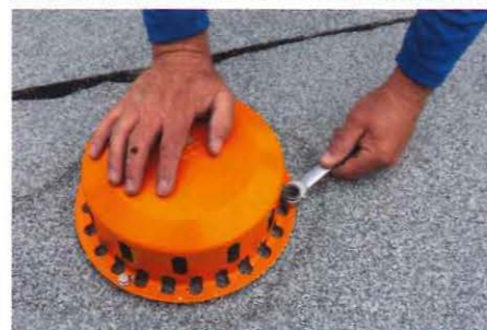
Für die einzelnen Gebäude genügt je ein Haupt- (silber) und ein Notentwässerungsstrang (orange). Die Hauben lassen sich bequem und einfach verschrauben.
