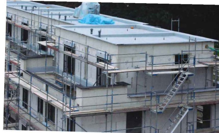
Gut zu erkennen: Das Gefälle des Flachdaches.
