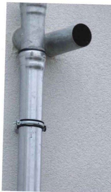
Abflussseite des Duoflux: Die Notentwässerung erfolgt über den Speier vor das Gebäude, die Hauptentwässerung führt über das Fallrohr in die Kanalisation. Die Lüftung stellt den Abfluss sicher.
