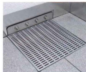
Entwässerung der Dachterrassen: Elegante Rinne zum Wandanschluss hin, unter dem Plattenbelag fließt das Niederschlagswasser zum Ablauf „Loro-Duoflux“. Gut zu erkennen ist das Anstaulement vor dem Notablauf. Die Edelstahl-Abdeckung nimmt das Design der Rinne auf – eine harmonisch gestaltete Gesamtlösung.
