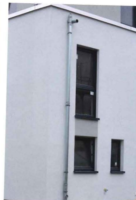
Abflussseite des Duoflux: Die Notentwässerung erfolgt über den Speier vor das Gebäude, die Hauptentwässerung führt über das Fallrohr in die Kanalisation. Die Lüftung stellt den Abfluss sicher.
