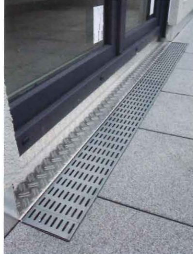
Entwässerung der Dachterrassen: Elegante Rinne zum Wandanschluss hin, unter dem Plattenbelag fließt das Niederschlagswasser zum Ablauf „Loro-Duoflux“. Gut zu erkennen ist das Anstaulement vor dem Notablauf. Die Edelstahl-Abdeckung nimmt das Design der Rinne auf – eine harmonisch gestaltete Gesamtlösung.
