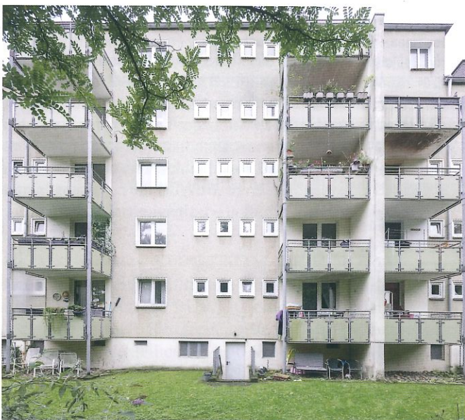
Bild 1. Wohngebäude in Köln-Zollstock: Die Balkone liegen zu den Innenhöfen und wurden 1991 angebaut.
