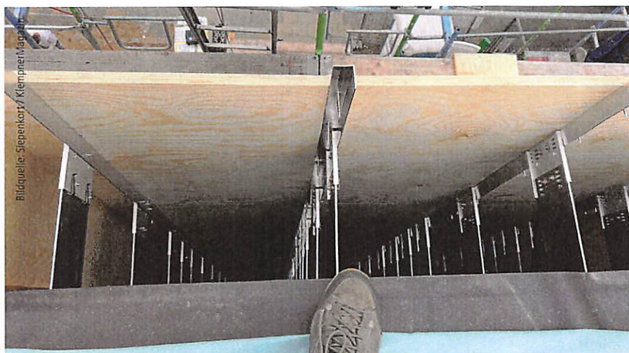
Zur „Verlängerung“ des Staffelgeschosses im Bereich des Hauseinganges erstellte das Nebeler-Team eine Distanzkonstruktion mit speziellen Konsolen und L-Profilen.
