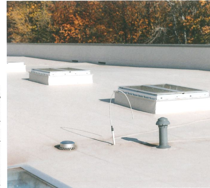
Über das Dach gelangt auch Tageslicht in die Halle – die Abflüsse für die Hauptentwässerung sind sauber in die Fläche eingebunden.
