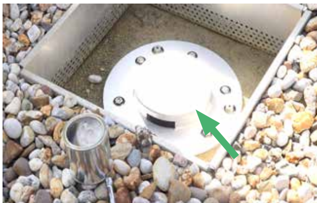
LORO-X VARIOFIT Retentionseinheit Einbau
