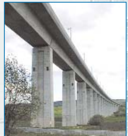
Tramo de la DB (Construcción de puentes)
