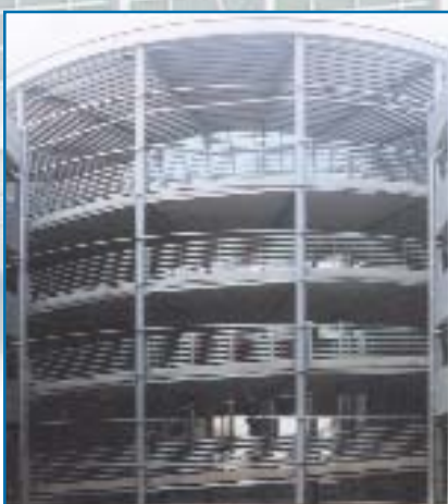
Aparcamiento del recinto ferial, Hannover
