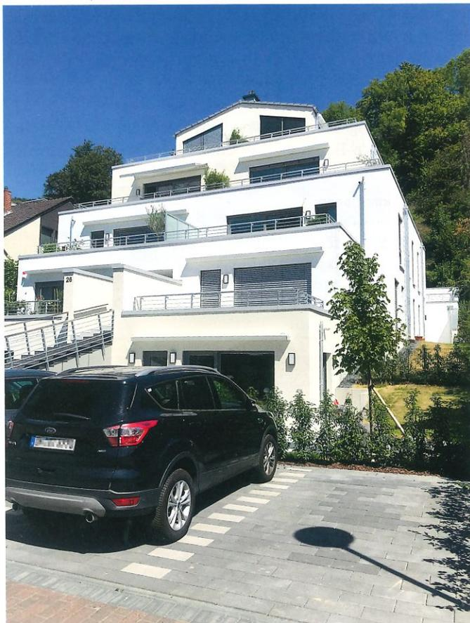
**Bild 1.** Ästhetische Entwässerung der Staffelgeschosse über Loro-X-Duostream Kaskadenentwässerung: Es genügt je ein Strang für Haupt- und Notentwässerung über alle Geschosse – die Fallleitung wird so zum gestalterischen Merkmal
