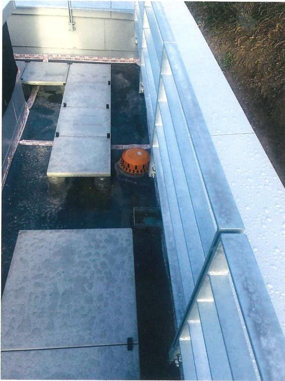
**Bild 3.** Die Notentwässerung (orange Haube) ist als Freispiegelströmung ausgelegt (Fotos: LOROWERK K.H.Vahlbrauk GmbH & Co.KG)
