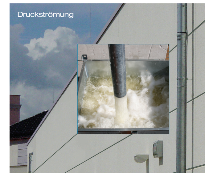
Weniger Fallleitungen und kleinere Nennweiten
