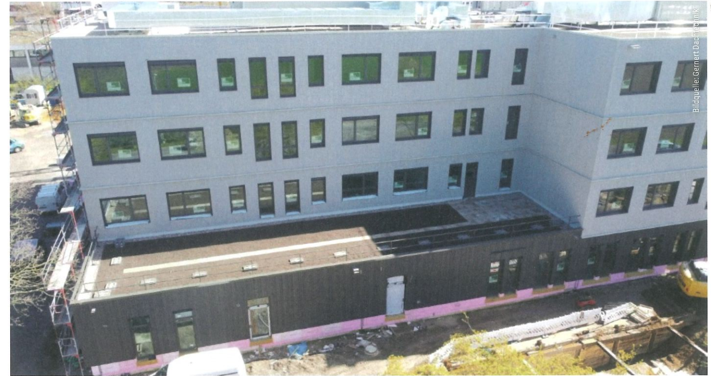
Ein Teil des begrünten Daches kann als Terrasse genutzt werden.
