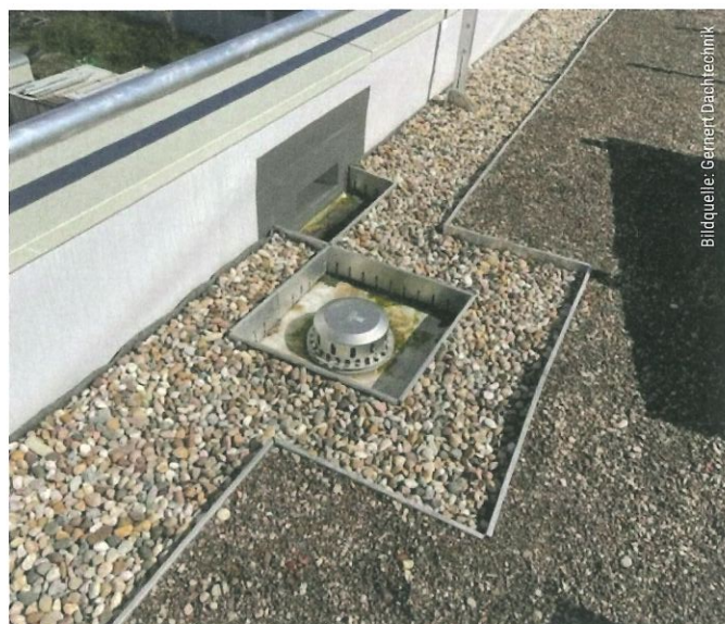
Speier und Hauptablauf: An der Attika ist umlaufend ein Kiesstreifen ausgeführt.
