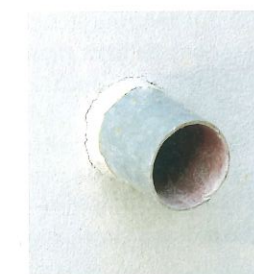
Minimaler Fassadendurchbruch für die Notentwässerung mit einem schmalen DN-50-Rohr.
