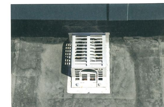
Auf dem nicht einsehbaren Flachdach geht es um (Abfluss-)Leistung. Durch die Wahl der Loro-Duoflux-Attika-Direktabläufe genügen zwei Ablaufpunkte, um die gesamte Fläche sicher zu entwässern.
