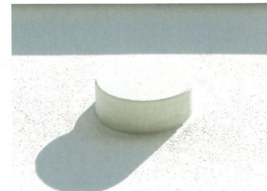
Damit die Entwässerung das Fassadenbild nicht stört, verlaufen die Fallleitungen hinter der Fassade. Nur für die Entlüftung der Rohre ist ein Durchbruch notwendig. Dies ist elegant mit einer „Wuppertaler Blende“ im Farbton des Fassadenputzes gelöst. Von unten ist die Blende geschlossen und fügt sich so harmonisch in die Fläche ein.
