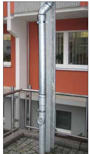
LORO-X Regenstand- und Regenfallrohre mit Leitungsversprung
