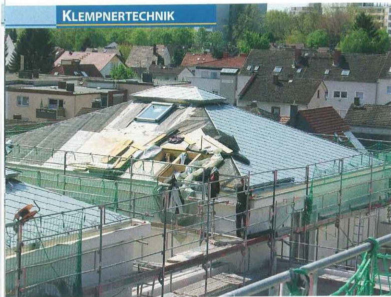
Zahlreiche Durchdringungen erschwerten den Arbeitsablauf.
