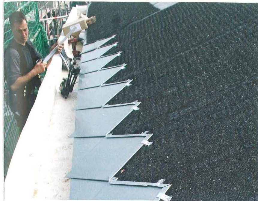
Damit die Schindeln gleichmäßig in den Grat einlaufen, erfolgte die Aufteilung jeweils von der halben Traufenlänge.
