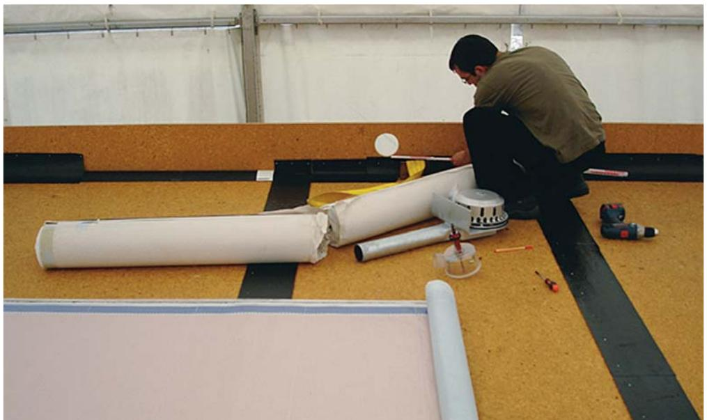
kam die Vakuumdämmung in Form von Paneelen (Fa. POREXTHERM).
