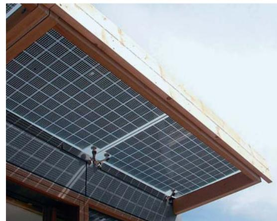
zung der Firma Interpane), zwischen denen perforierte Zellen eingebettet sind. Diese, von der Fa. Sunways hergestellten und gesponsorten Spezialzellen sind mit geringem Abstand zueinander angeordnet. Durch die Größe dieser Abstände und die Perforation lässt sich der Grad der Lichttransmission und des Energiegewinns auf die jeweiligen Anforderungen anpassen.
