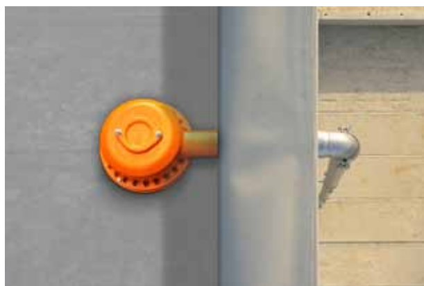
Zabudovaný hotový systém odvodňování střech s podtlakovým odtokem
