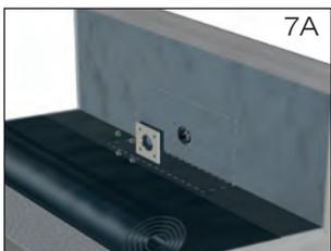
1.9 Bei Ausführung DN 50 Kompressionsdichtung über Dampfsperrbahn anbringen und mit Losflansch und beiliegenden Schrauben verklemmen (Bild 7A). Beiliegende Schrauben mit Steck- oder Ringschlüssel SW 17 gegenüberliegend anziehen. Anzieh-Drehmoment: 20 Nm (Dampfsperrbahn aus Bitumen) bzw. 30 Nm (Dampfsperrbahn aus Kunststoff). Dichtelement in Muffe des Schiebeflansches einlegen.
