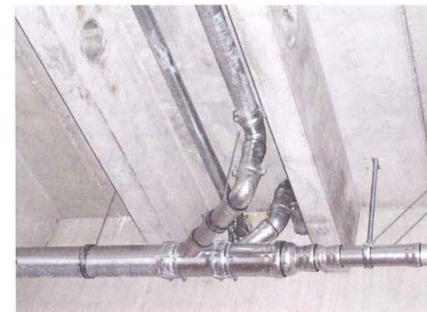
Zusammenführung zweier Sammelleitungen in eine Hauptammelleitung
