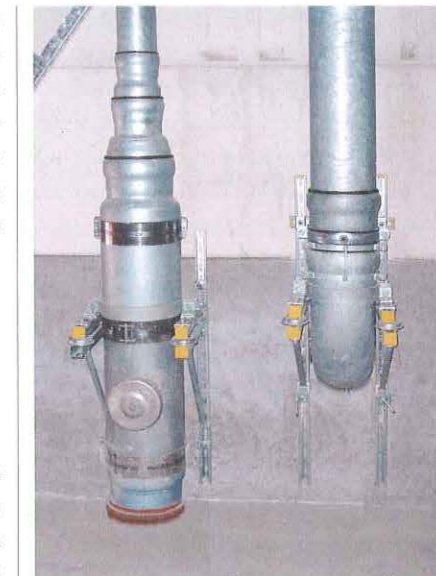
Der Fußpunkt zweier Falleleitungen. Rechts die Notentwässerung mit Bogen und Rohrstrecke durch die Wand mit freiem Auslauf. Links die Hauptentwässerung mit dem Übergang von der Vollfüllung oberhalb der Formstücke zur Beruhigungsstrecke (mit Revisionsöffnung) als Freispiegelentwässerung
