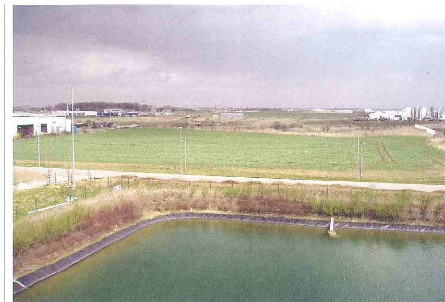
Das Hauptablaufsystem entwässert die Regenmassen über Grundleitungen in ein Regenrückhaltebecken
