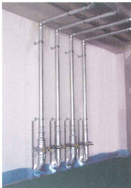
Vier nebeneinander verlaufende Falleleitungen vom Notablaufsystem, die ins Freie auslaufen
