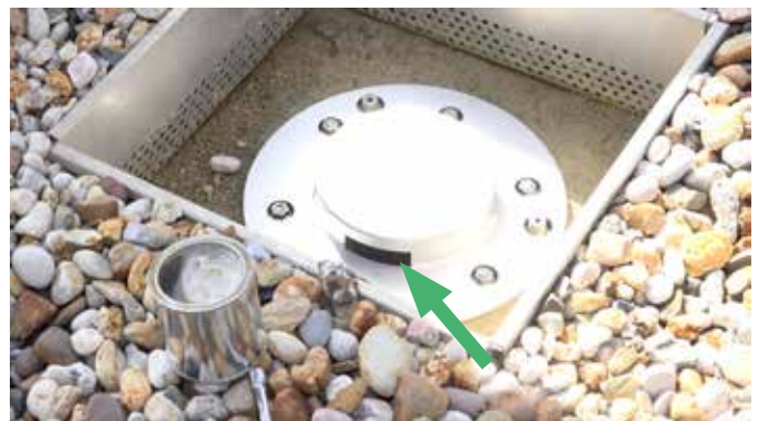
LORO-X VARIOFIT Retentionseinheit Einbau
