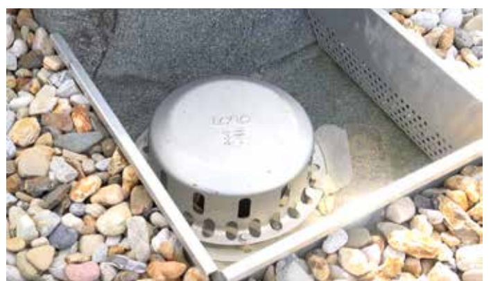
Mit Retention nachgerüster LORO-X RAINSTAR Attikaablauf
