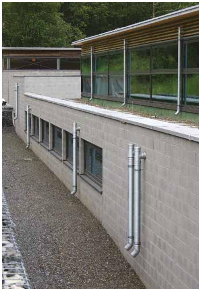
*Les systèmes extérieurs d'évacuation des eaux pluviales avec évacuation principale et évacuation de secours garantissent le refoulement durable et sûr des eaux pluviales.*
