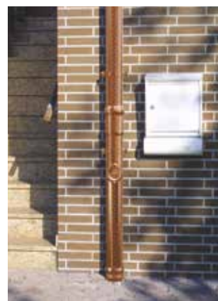
Nedløpsrør av forsinket stål, rustfritt stål eller kobber
