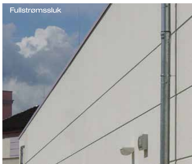
Færre falledninger og mindre rørdimensjoner
