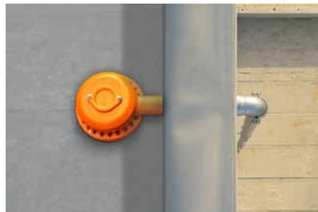
Installert ferdig-attikadrenerings-system med fullstrømssluk
