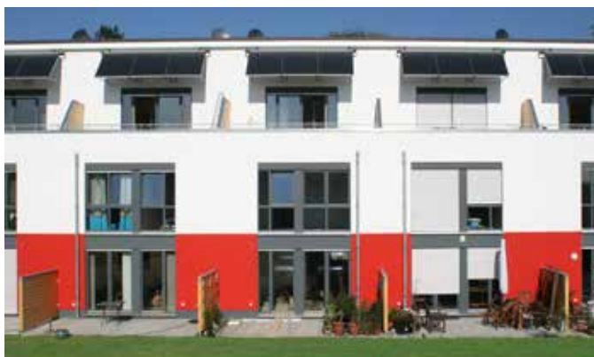
Lakásépítés: Párkány- és erkély vízvezetés
