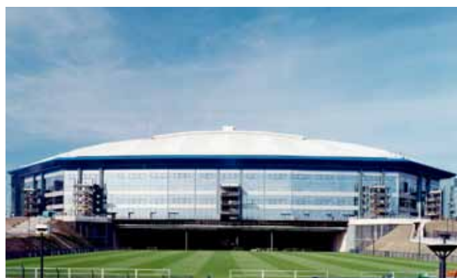
Stadiony i budownictwo specjalne
