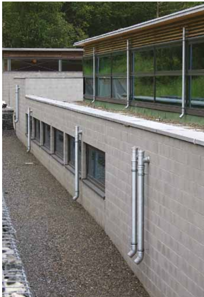
Usytuowane na zewnątrz systemy odwodnienia dla odwodnienia głównego i awaryjnego zapewniają trwałe i niezawodne odprowadzanie wody.
