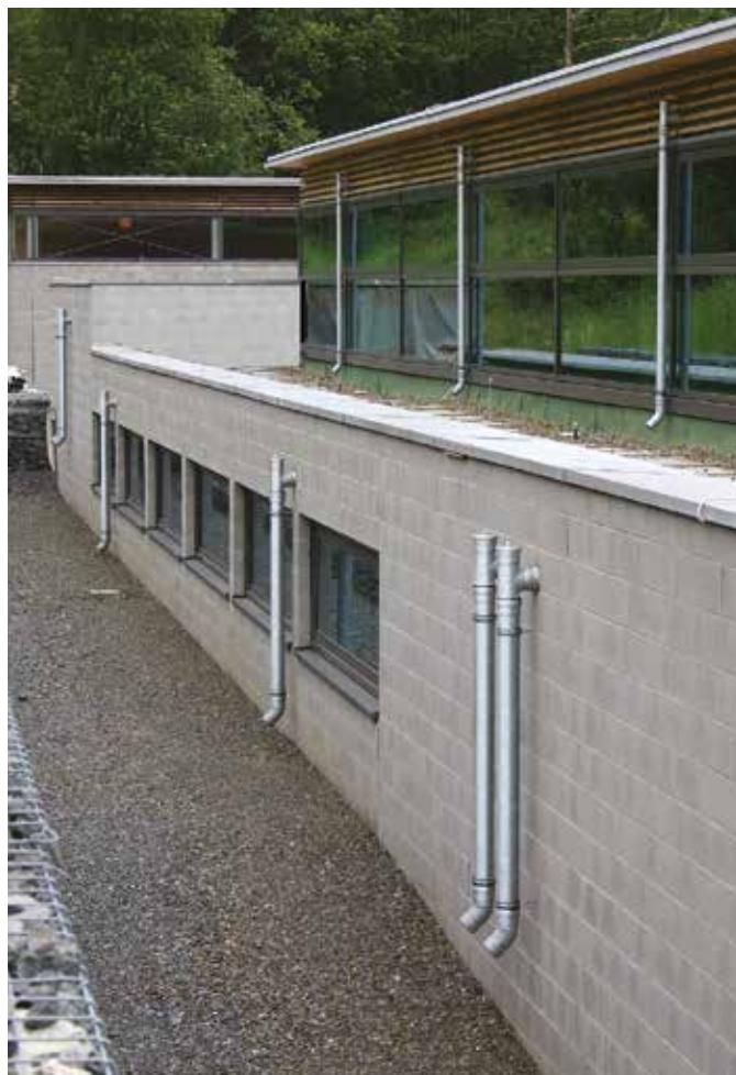
Udvendige afvandingssystemer til hoved- og nødafvanding garanterer en langtidsholdbar og sikker vandafledning.
