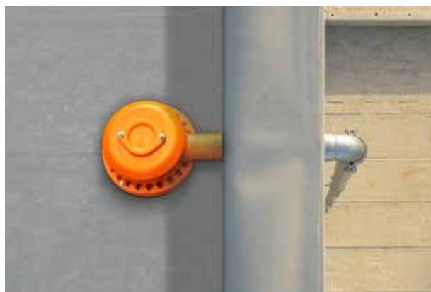
Eingebautes Fertig-Attikaentwässerungssystem mit Druckströmung
