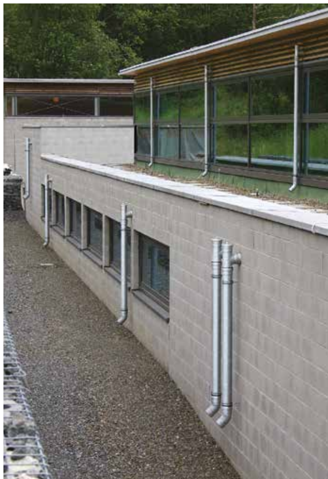
Außen liegende Entwässerungssysteme für Haupt- und Notentwässerungen gewähren eine langfristig gesicherte Wasserableitung.
