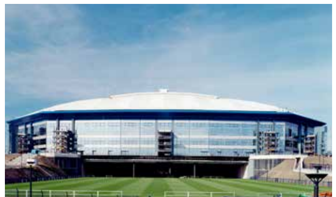
Stadions en speciale bouwwerken
