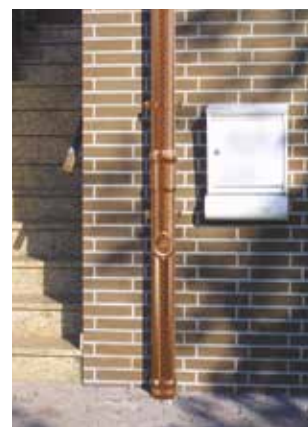
standleidingen van thermisch verzinkt staal, roestvast staal en koper
