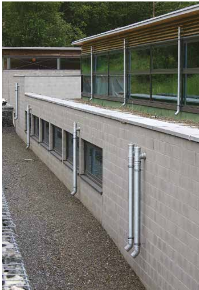
Buitenliggende afvoersystemen voor hoofd- en noodafvoeren bieden een veilige waterafvoer op lange termijn.
