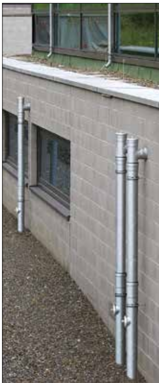
LORO-X-standpijpen en -valpijpen met een LORO-X-dakrandafvoer
