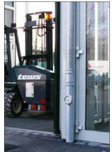
LORO-X-standpijpen in omgevingen waarin rekening moet worden gehouden met mechanische beschadiging.
