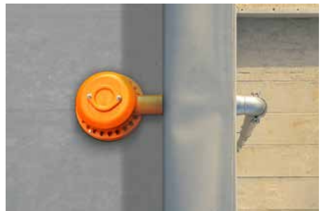
Geïnstalleerde dakrandafvoer met aanvulling
