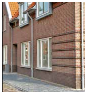
LORO-X-standpijpen bij woningbouw
