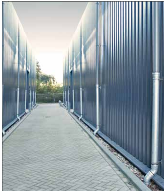
LORO-X-standpijp zonder reinigungsopening, met pijp-offset naar de grondleiding
